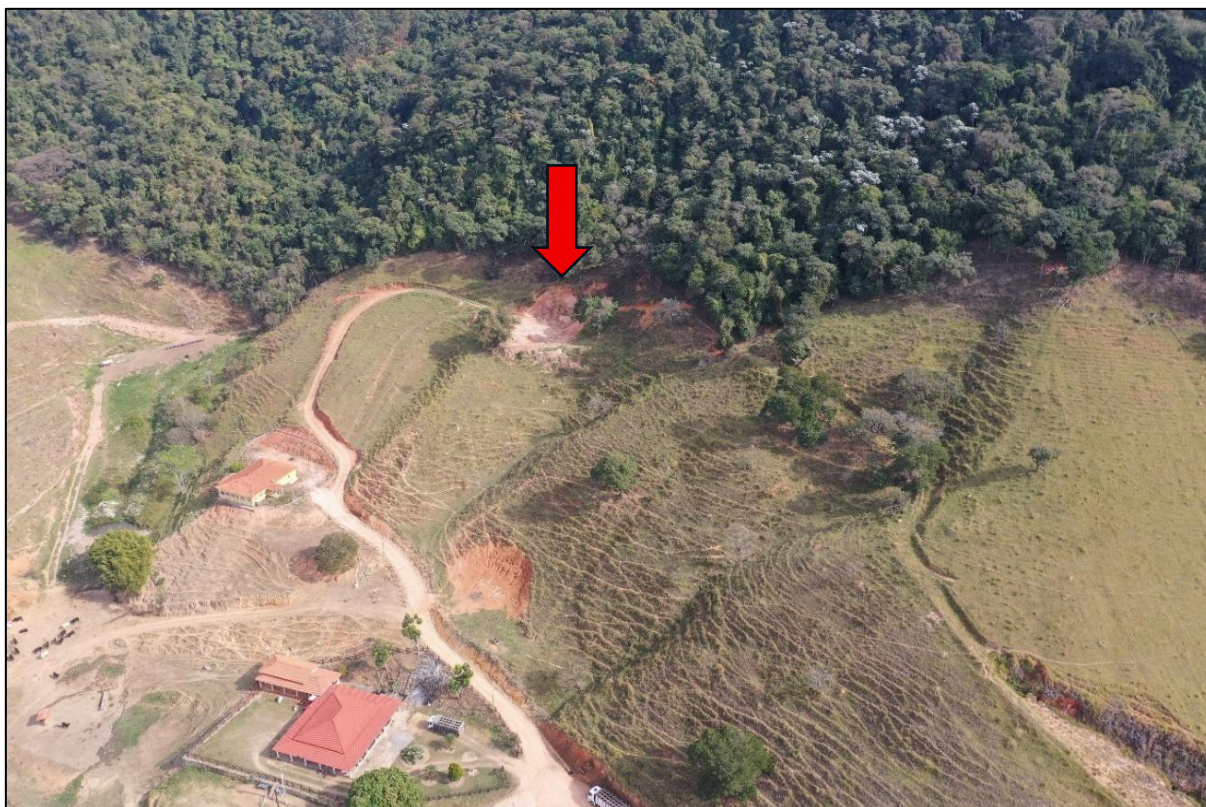
Figura 10: Vista da segunda área de interesse de extração apontada pela seta vermelha.
