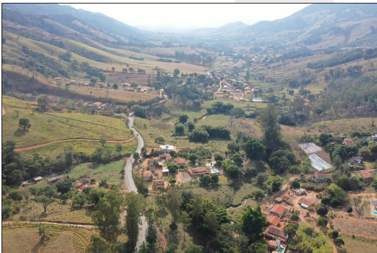
Figura 13: Vista do lado norte da propriedade.
