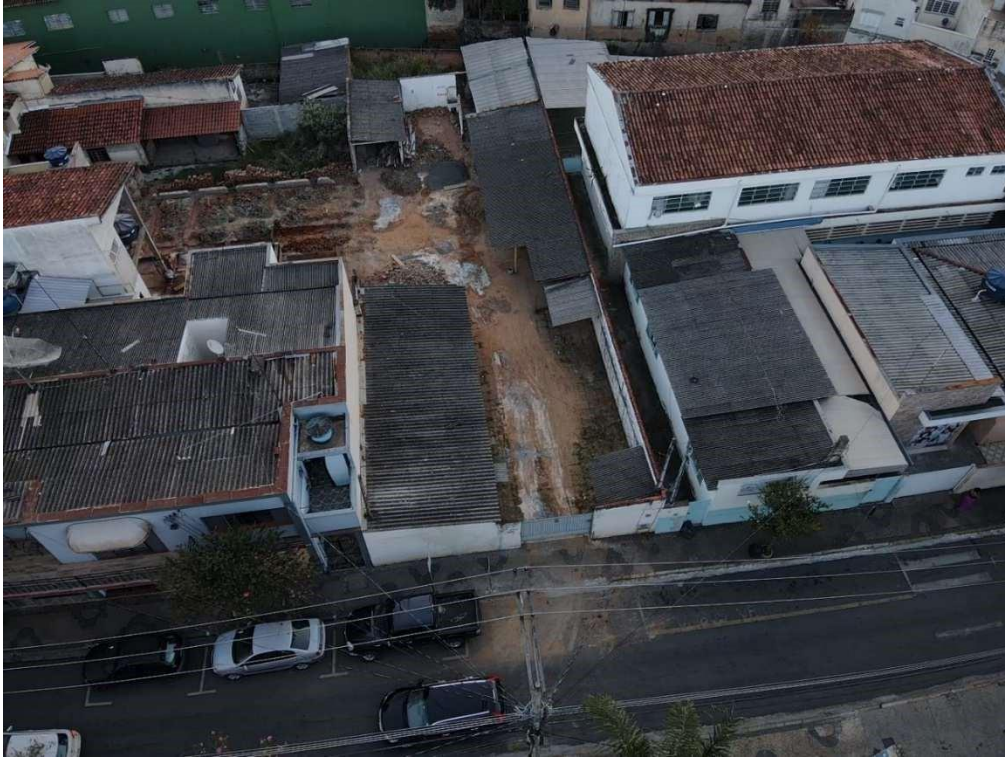
Figura 2: Vista Aérea do terreno por drone. Mantovani, 2024
