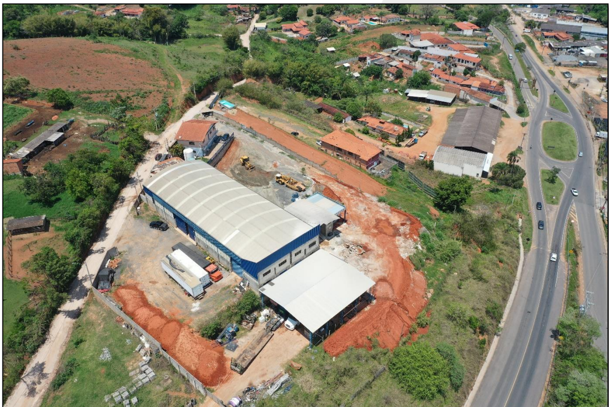
Figura 19: Fotografia aérea de drone voltada para leste. Fonte: COAMI,2022.
