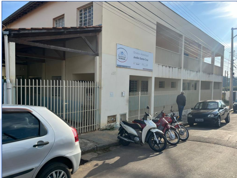
Figura 11 – Imagem tomada no local – Creche Municipal situada à Avenida São Paulo, no bairro Jardim Santa Cruz.
