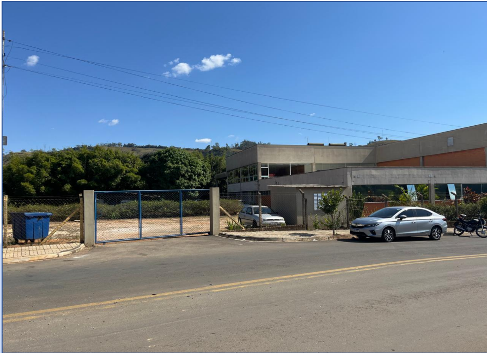
Figura 07 – Imagem tomada no local da área de implantação do empreendimento. Observar a topografia plana e o amplo pórtico de acesso ao seu interior.
