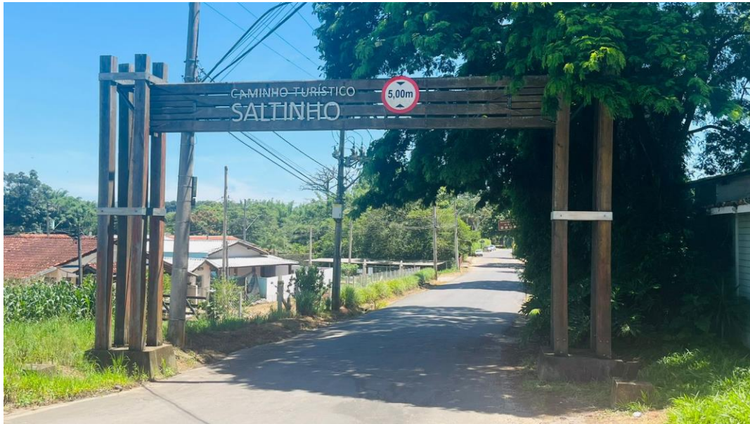
Figura 21 – Estrada principal de acesso a área do empreendimento
