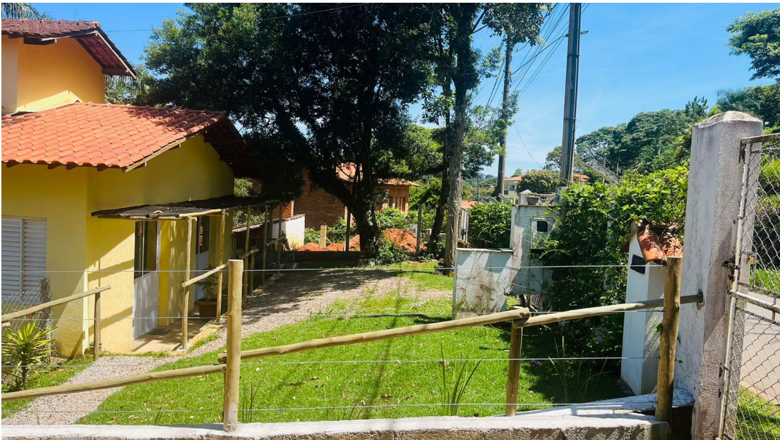
Figura 12 – Fachada lateral do empreendimento
