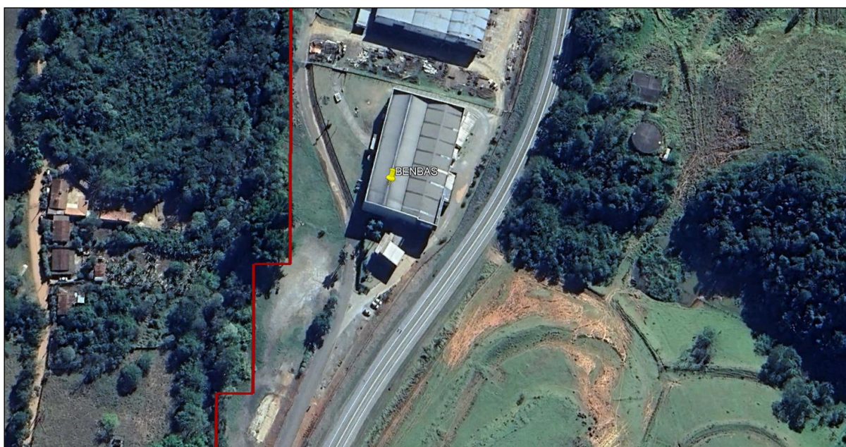
Figura 04: indicação do galpão instalado para o desenvolvimento da atividade de envase de água mineral.
