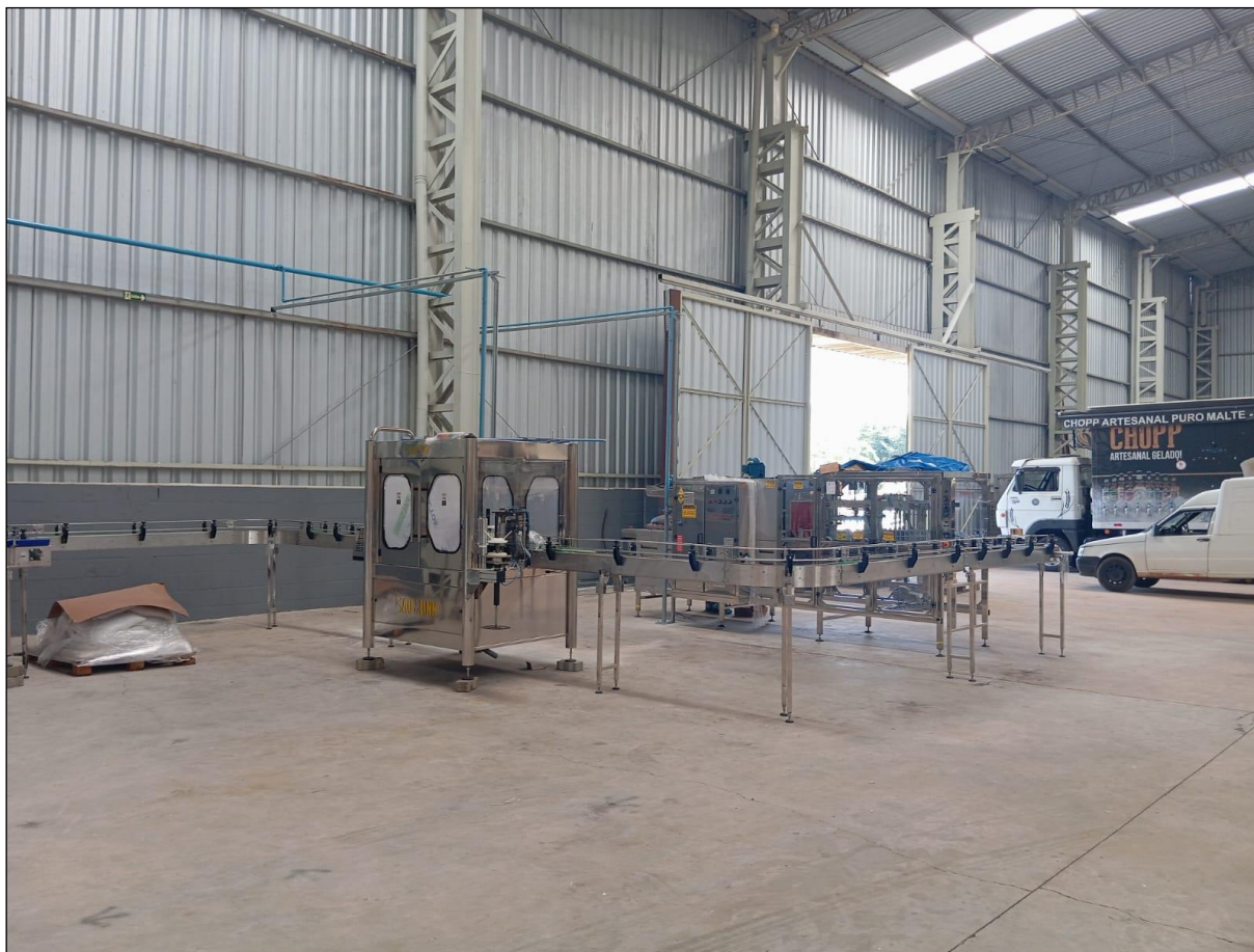
Foto 02: Interior do galpão industrial com a presença do maquinário para o envase de água mineral
