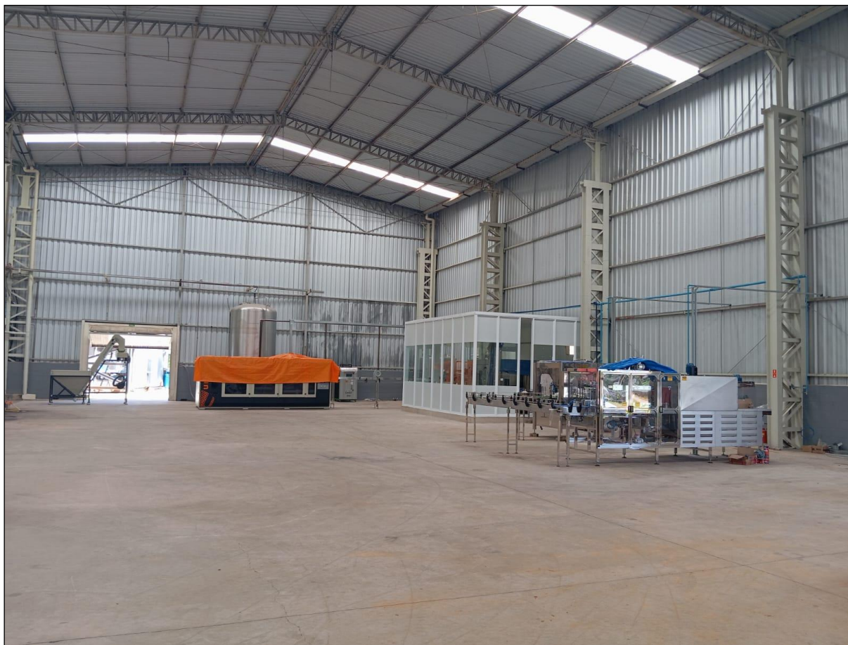
Foto 03: Interior do galpão industrial com a presença do maquinário para o envase de água mineral
