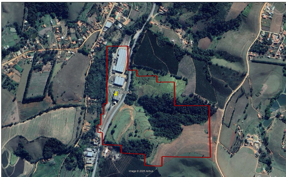
Figura 03: indicação do galpão instalado para o desenvolvimento da atividade de envase de água mineral.
